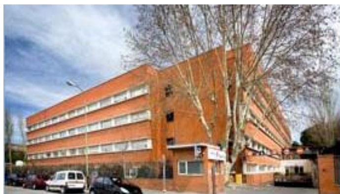
Figura 3 Exterior del hospital Moncloa (fuente: web)
