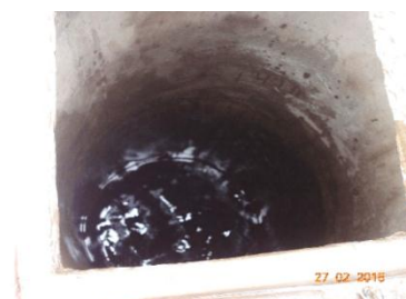
Interior de pozo típico existente
