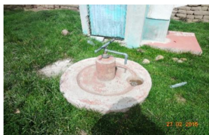
Pozo Típico existente – bomba manual
