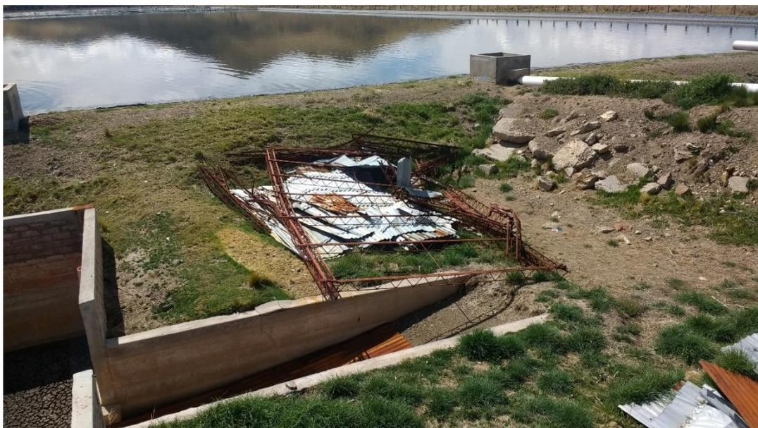
*Figura N° 43: Digestor de Lodos sin cobertura.*
