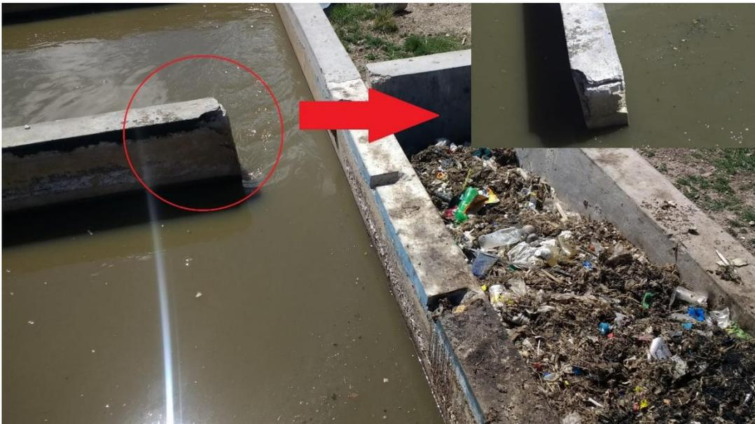
*Figura N° 32: falla de muros de Sedimentadores Secundarios de la PTAR*
