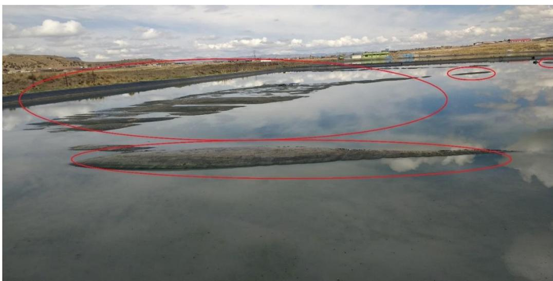
*Figura N° 53: acumulación de gases dentro de la geomembrana*
