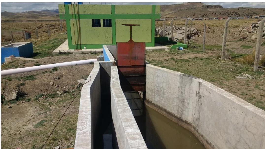
*Figura N° 22: Compuertas del Desarenador de la PTAR*
