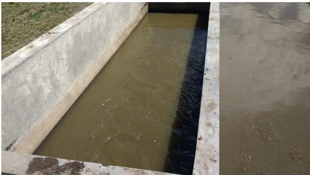
*Figura N° 28: Desgrasado de la PTAR*
