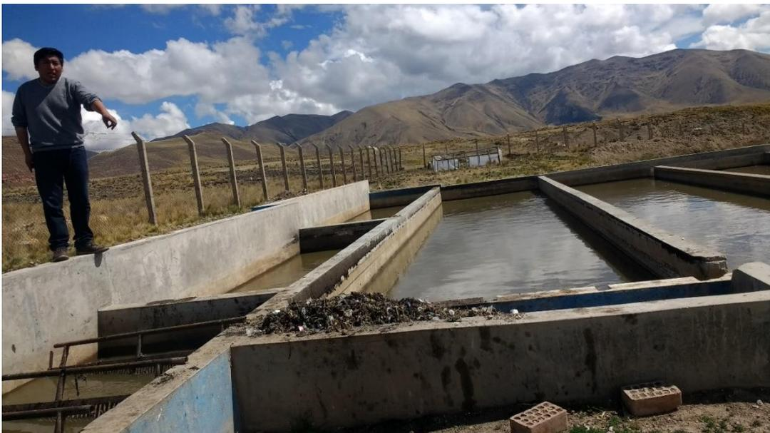
*Figura N° 26: La cámara de rejas de la PTAR*
