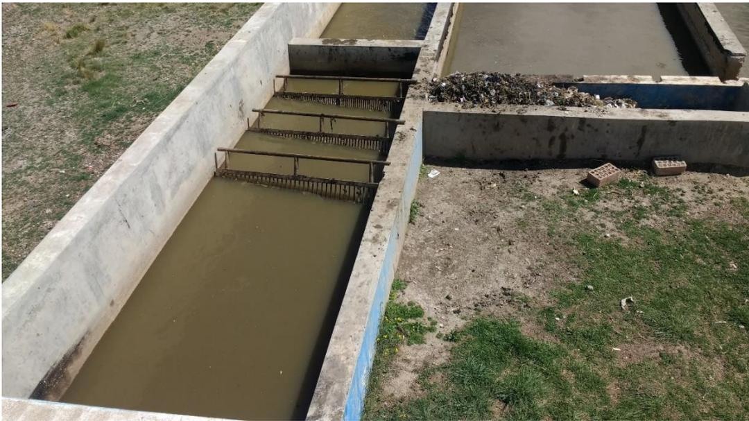
*Figura N° 25: La cámara de rejas de la PTAR*
