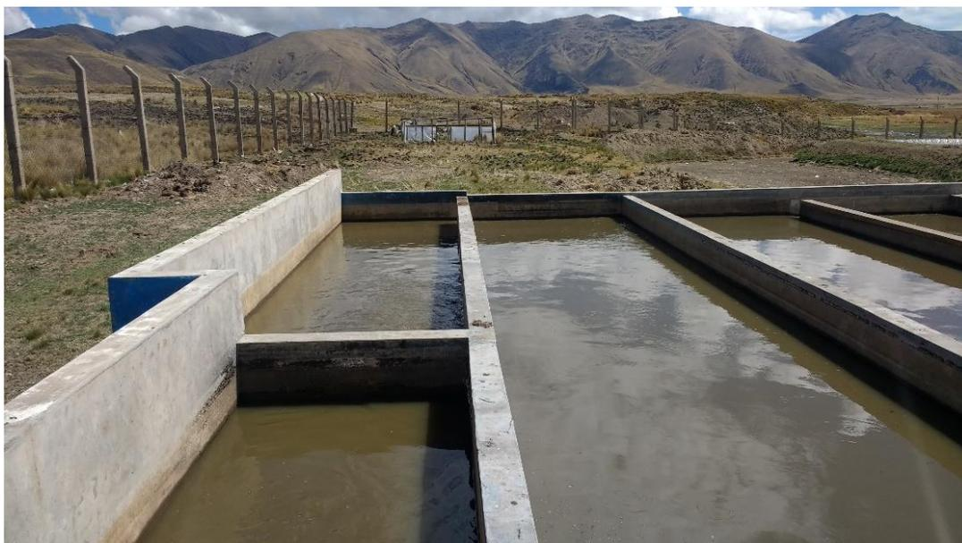
*Figura N° 29: Sedimentador Primario de la PTAR*
