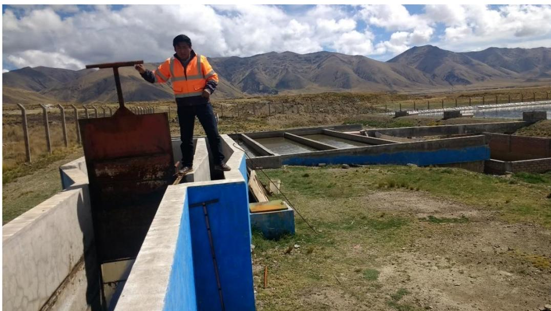
*Figura N° 20: Desarenador de la PTAR*
