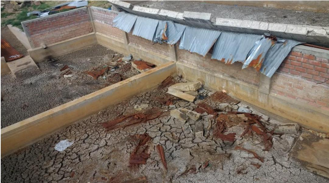
*Figura N° 41: Digestor de Lodos sin cobertura.*
