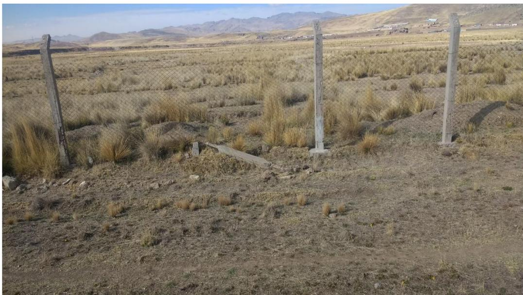
*Figura N° 62: Soportes de cerco perimétrico caídos.*
