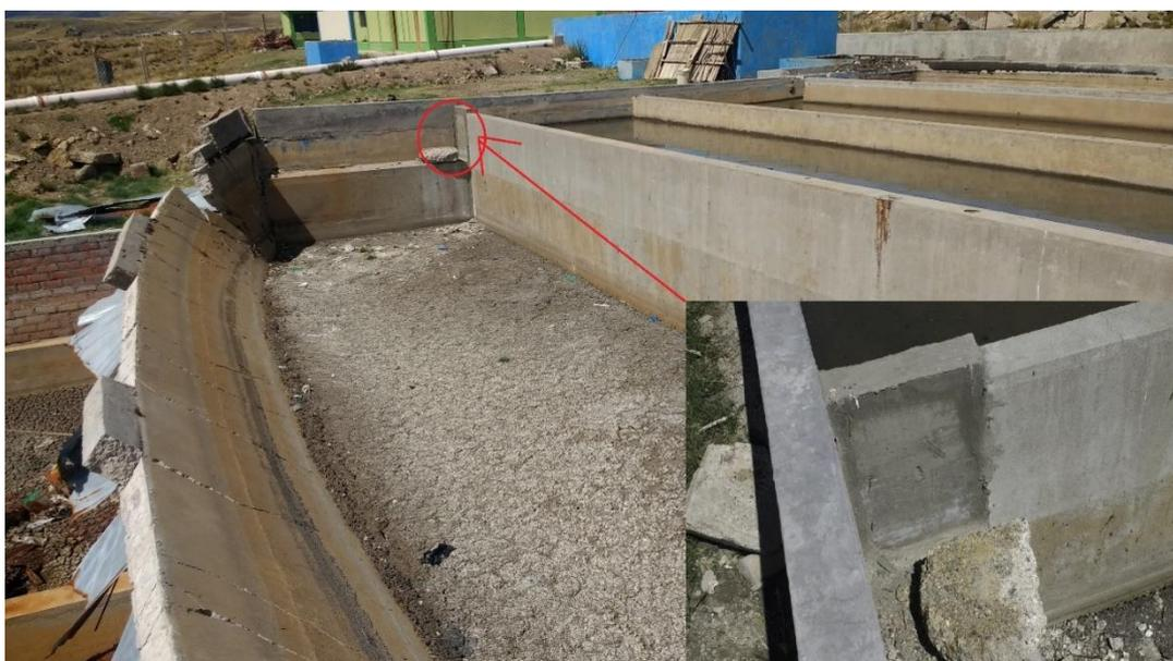
*Figura N° 35: Tercer sedimentador inoperativo, tapa improvisada para redireccionamiento.*
