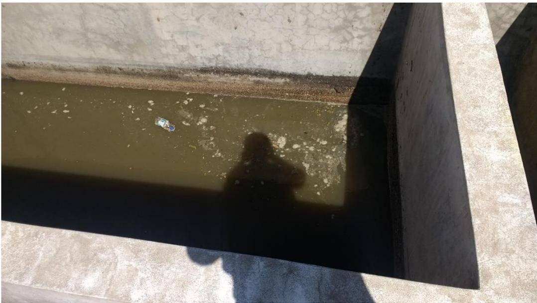
*Figura N° 23: Suciedad encontrada en el Desarenador de la PTAR*
