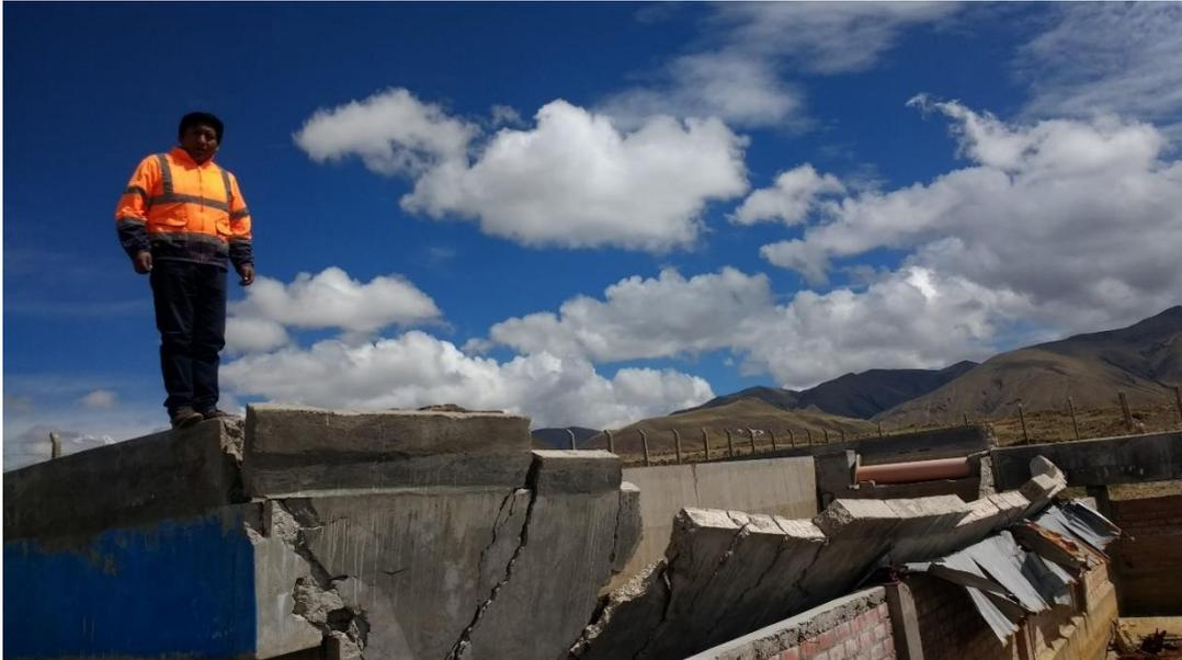
*Figura N° 33: Colapso de muro cuarto Sedimentador Secundario de la PTAR*
