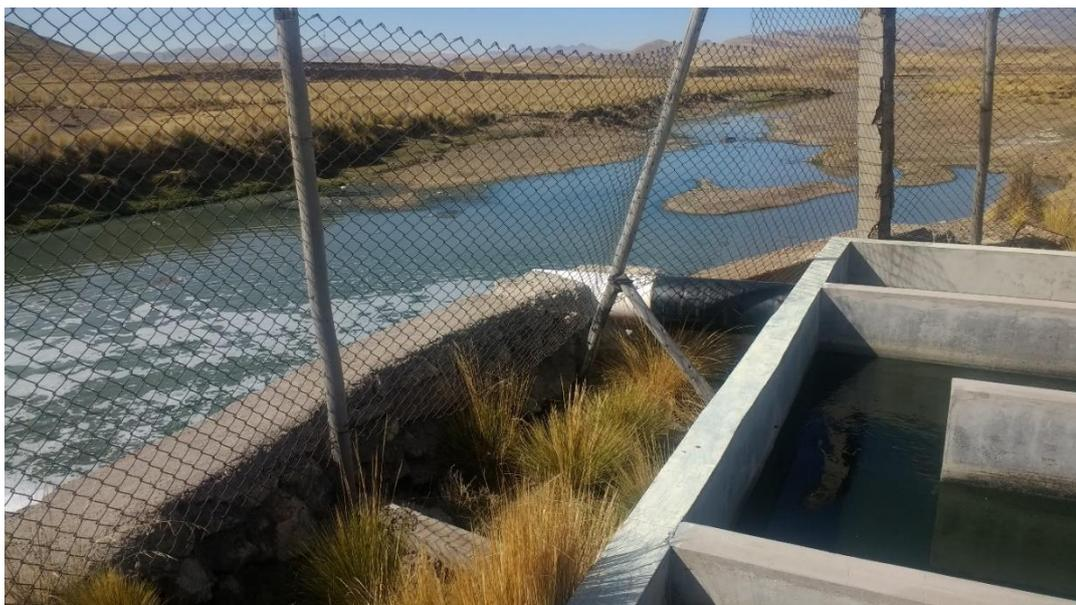
*Figura N° 59: tubería de salida de la PTAR.*
