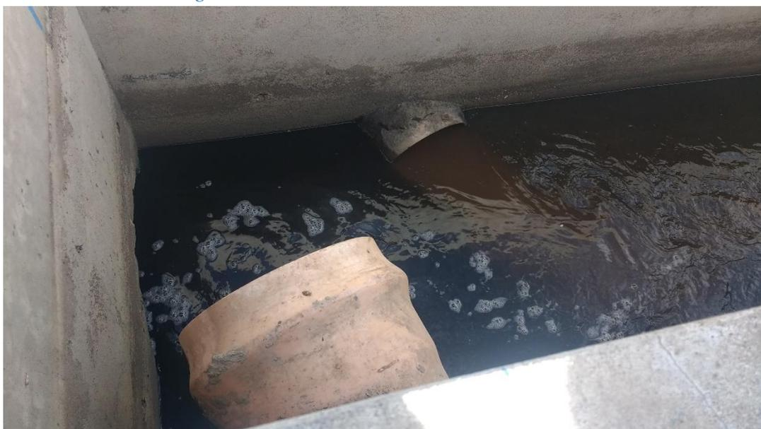
*Figura N° 18: Tuberías de llegada en la Cámara de reunión de la PTAR*
