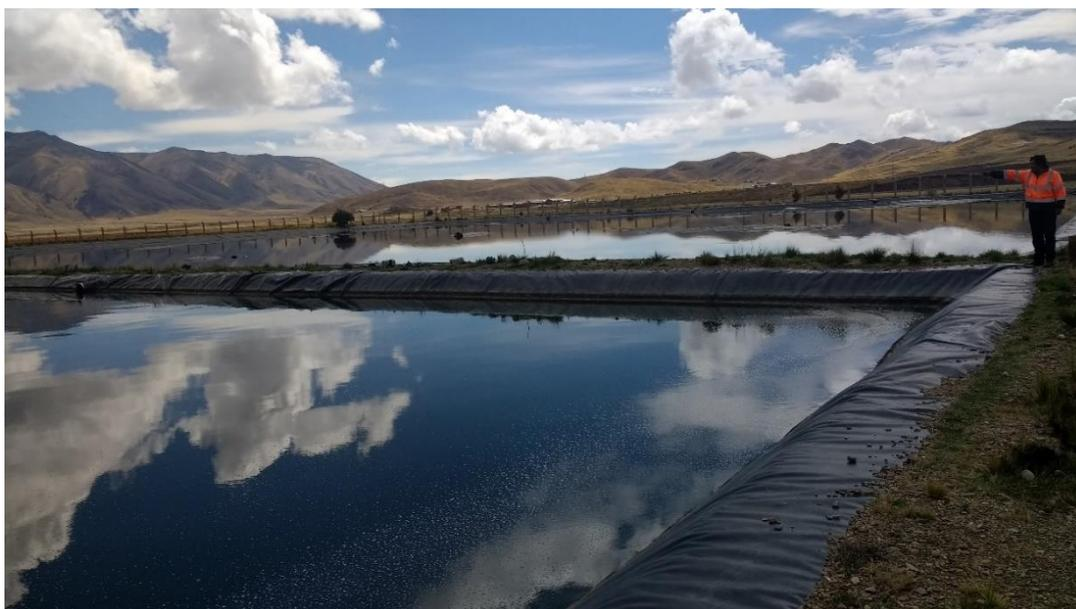
*Figura N° 49: Laguna de maduración secundaria de la PTAR*
