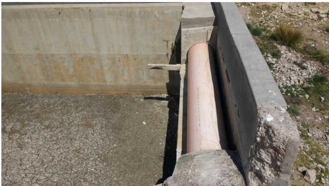
*Figura N° 36: Pase provisional, entre el tercer sedimentador y laguna de maduración.*
