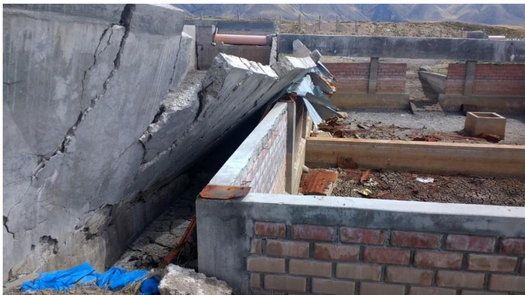
*Figura N° 42: Derrumbe de Sedimentador Secundario*
