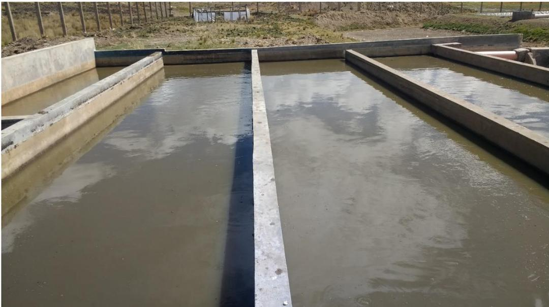
Figura N° 30: Sedimentadores Secundarios de la PTAR
