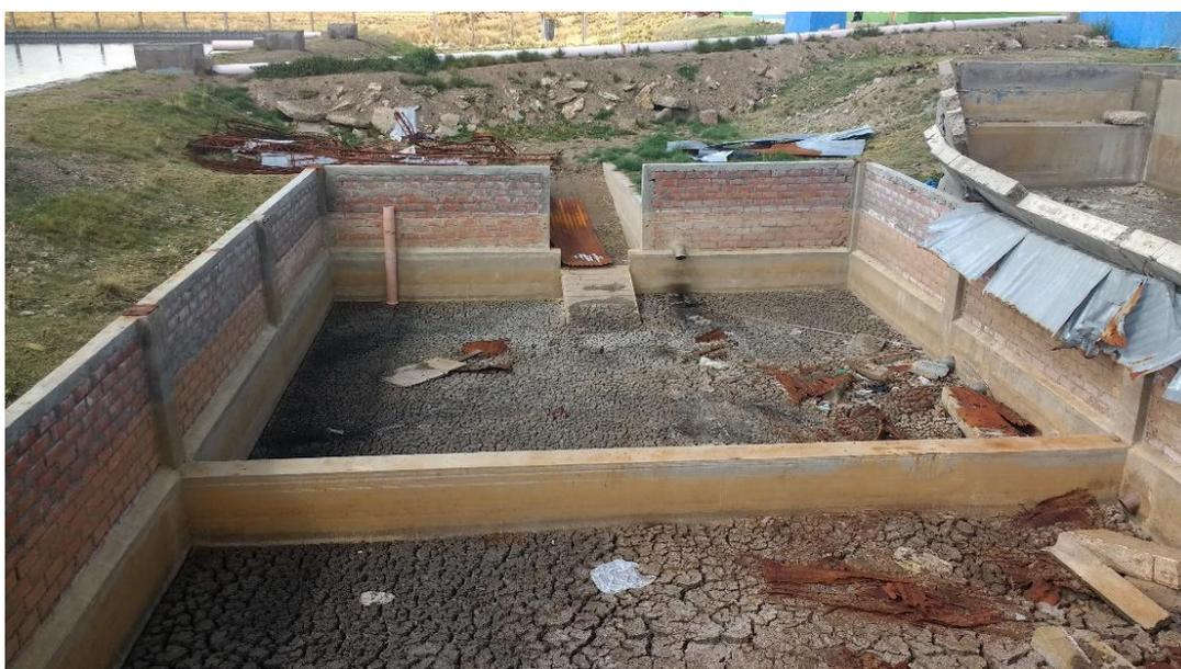
*Figura N° 38: Digestor de Lodos de la PTAR*
