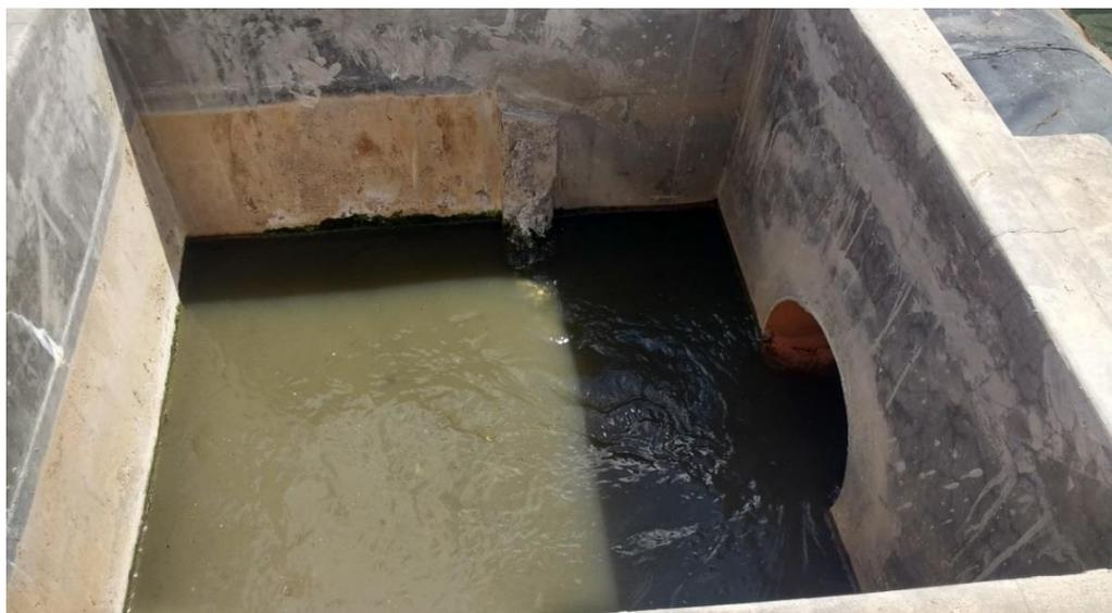
*Figura N° 45: caja de distribución de agua residual.*
