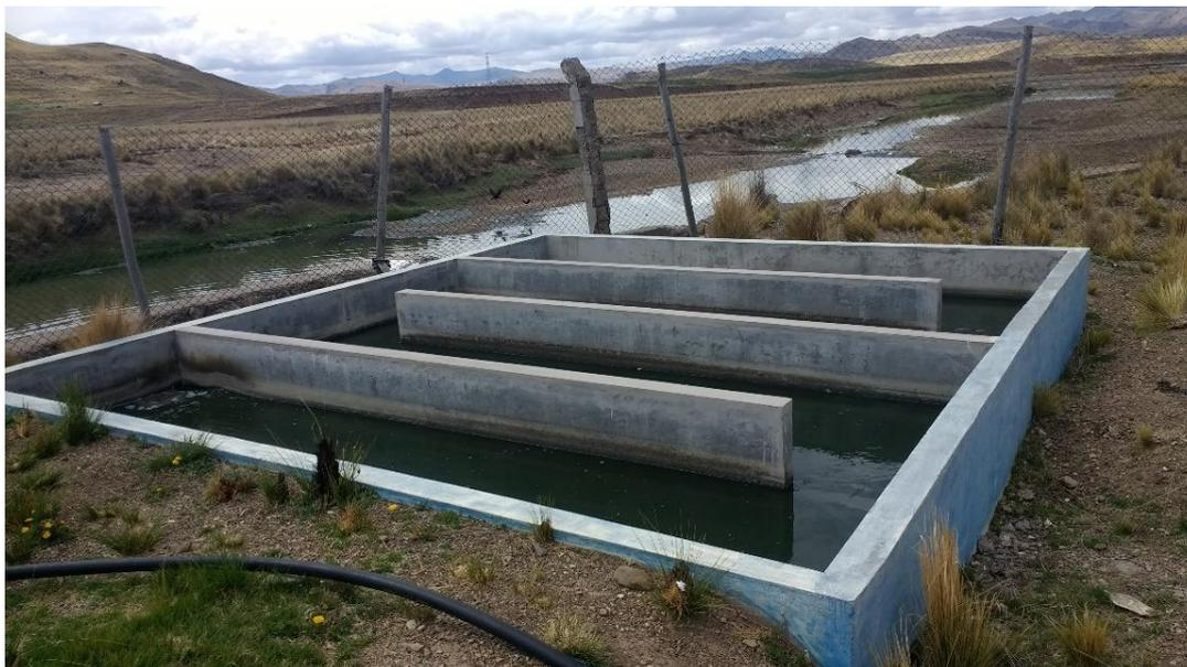
*Figura N° 55: Cámara de Cloración de la PTAR*
