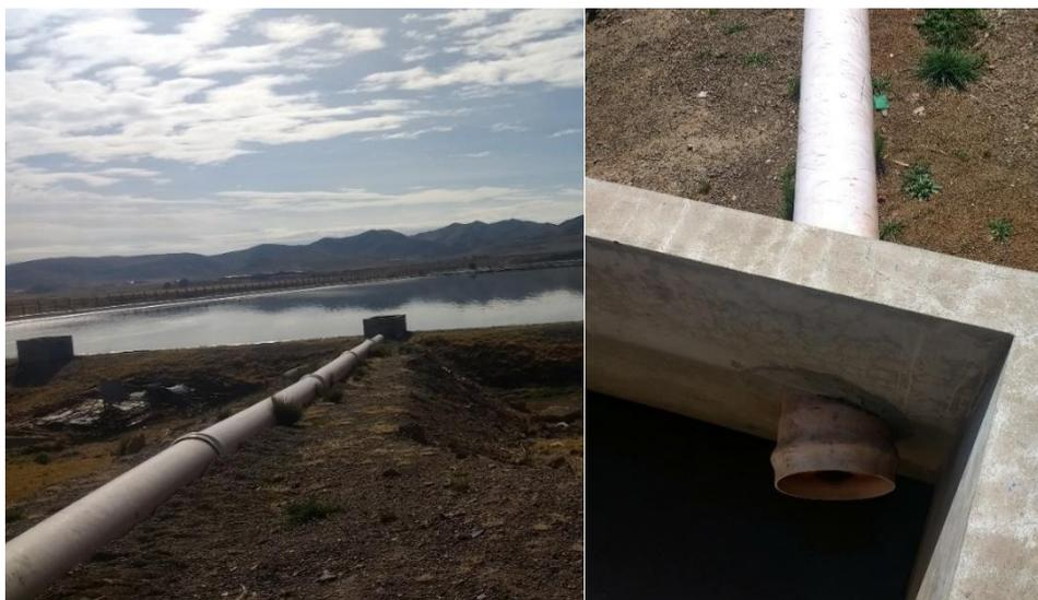
*Figura N° 19: Tuberías de salida directa hacia lagunas de maduración en PTAR*
