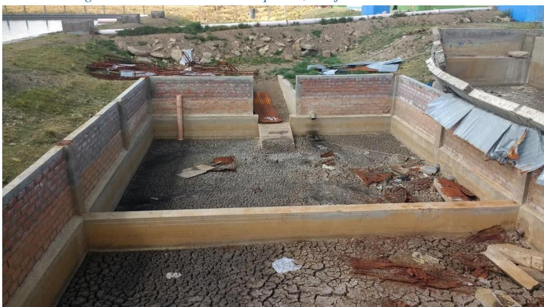
*Figura N° 40: Digestor de Lodos sin cobertura.*
