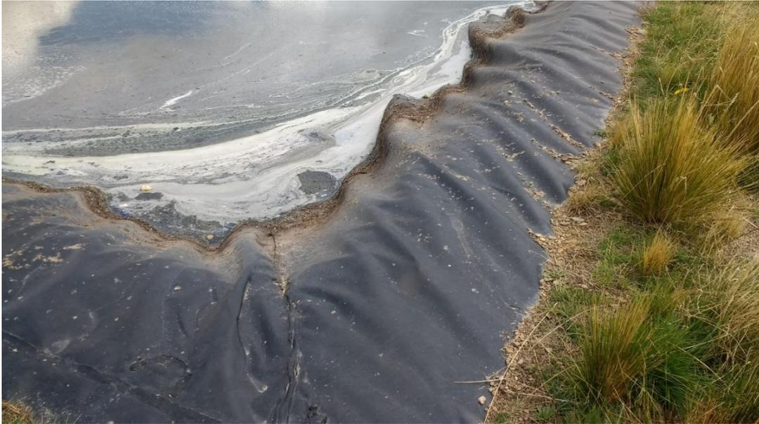
*Figura N° 72: Zona de ubicación del corto circuito hidráulico-laguna secundaria*
