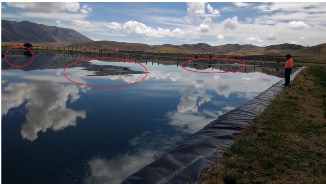
*Figura N° 52: Levantamiento de la geomembrana.*
