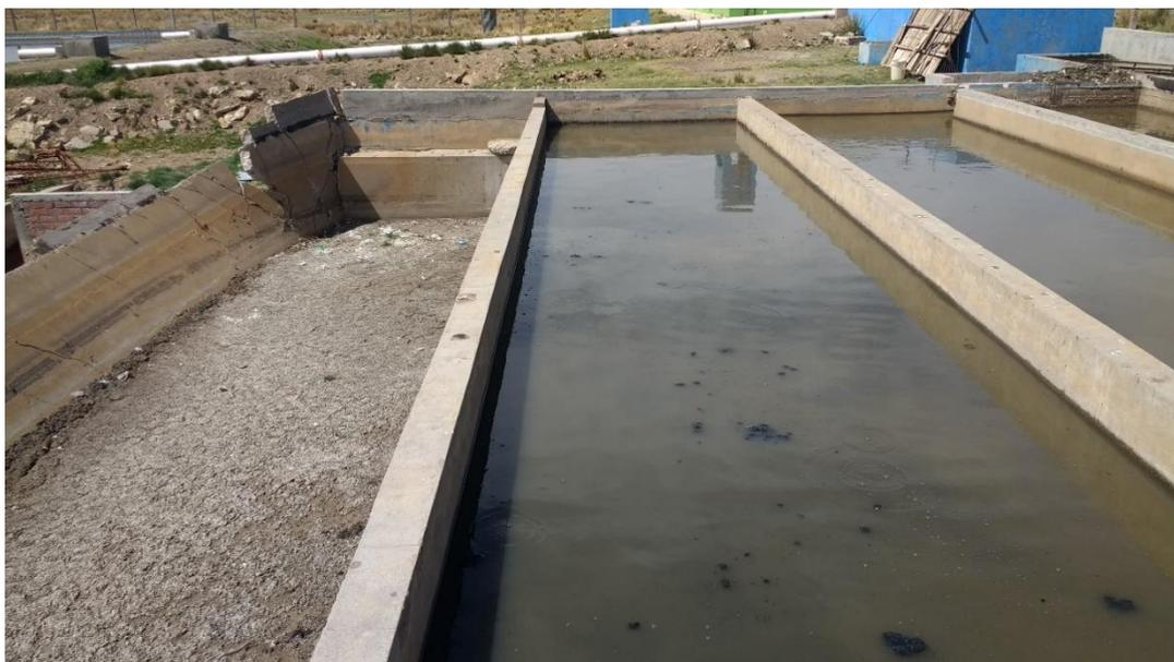
*Figura N° 34: Tercer sedimentador inoperativo de la PTAR.*
