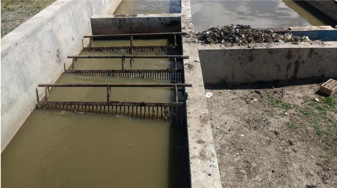
*Figura N° 24: La cámara de rejas de la PTAR*
