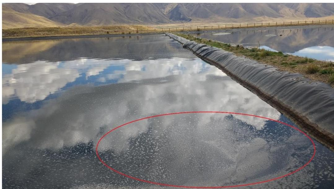
*Figura N° 71: Zona de ubicación del corto circuito hidráulico-laguna primaria.*
