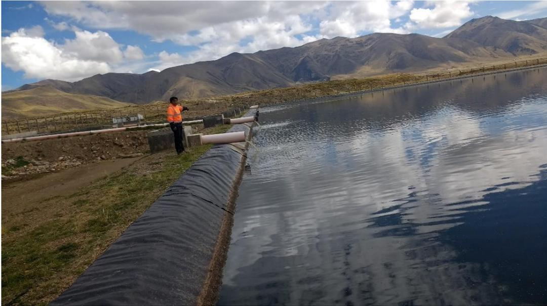
*Figura N° 44: Laguna de maduración primario de la PTAR*
