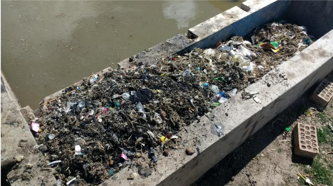
*Figura N° 27: La cámara de rejillas de la PTAR*
