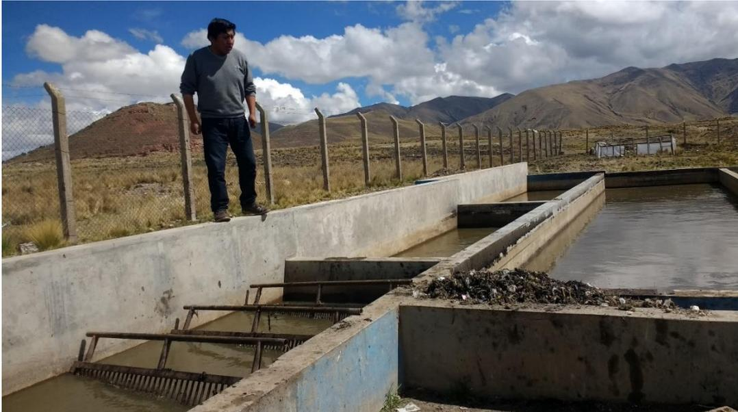
*Figura N° 67: Desgrasador y sedimentador primario.*
