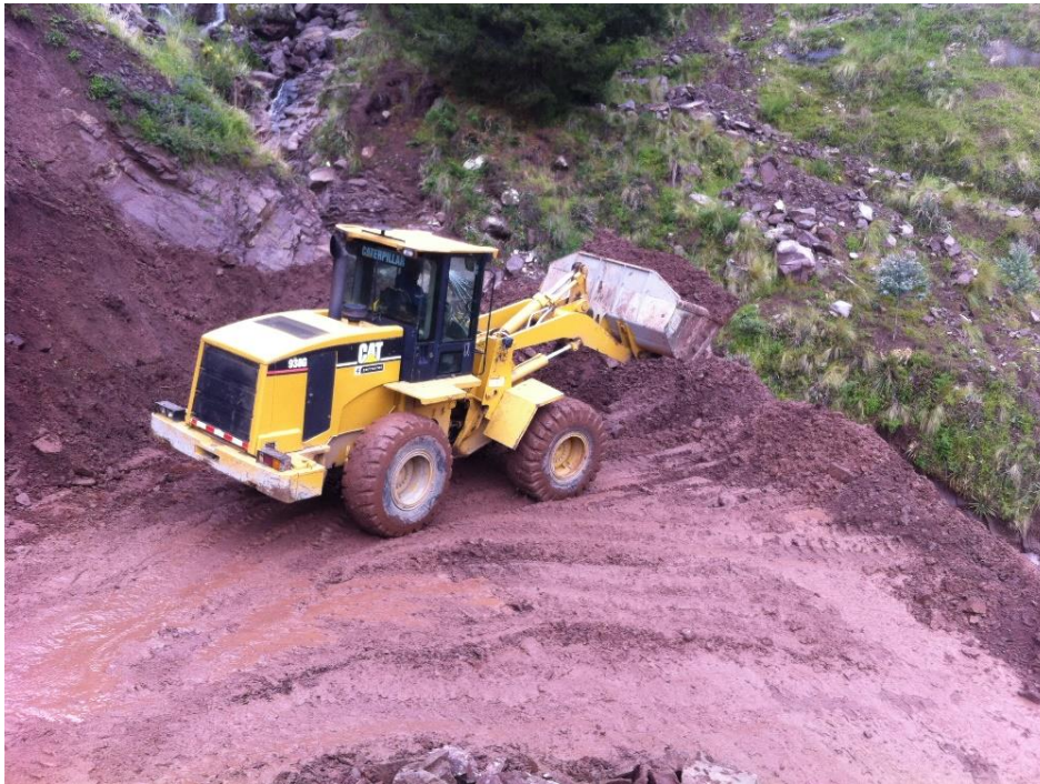
Figura A. 1: Cargador Frontal CAT 938G en movimiento de tierra
