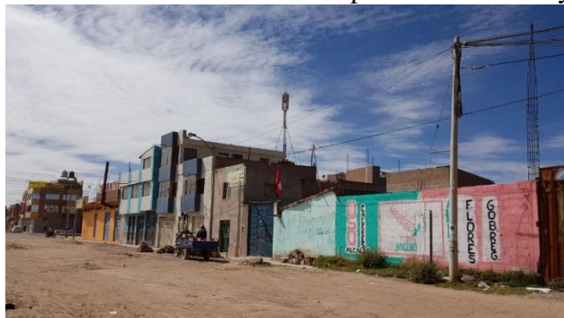
ANEXO N° 17: Foto encuentro entre puente San Isidro y zona A
