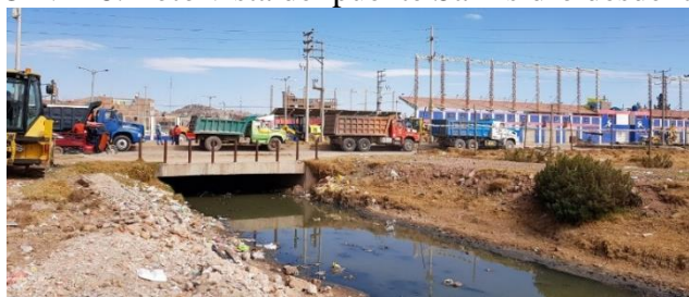
ANEXO N° 18: Foto vista del puente San Isidro desde la zona B
