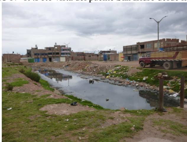
ANEXO N° 19: Foto vista del puente San Isidro desde la zona B
