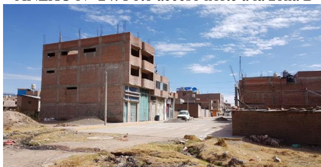
ANEXO N° 24: Foto acceso norte a la zona B
