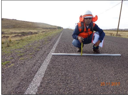
FOTO N° 01: Depresiones y Parches en mal estado
