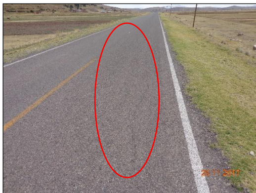
FOTO N° 03: Fisuras longitudinales y Fisuras de Borde
