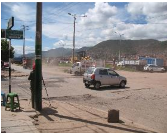
Figura 65. Vía Expresa Av. 28 de Julio/Av. Tomás Tuyro Tupac
