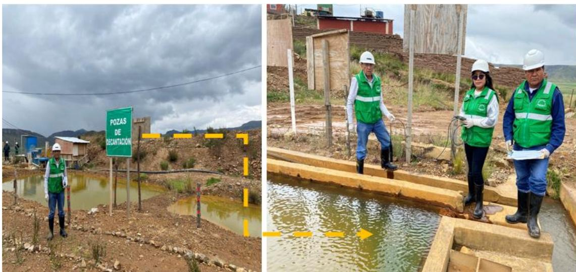
Se realizaron la toma de datos de los parámetros fisicoquímicos con el apoyo de un equipo Multiparámetro Hanna Instruments HI9829, utilizando un registro de datos en las pozas de sedimentación.
