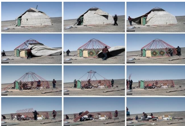
Armado y desarmado de la Yurta
