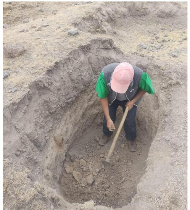
*Ilustración 4; En la imagen adjunta se evidencia, la extracción de muestra para los ensayos de laboratorio.*
