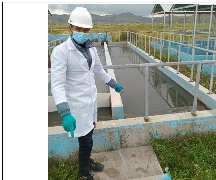
Descripción: Verificación in situ del sedimentador horizontal en el mes de abril.
