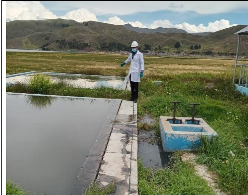
Descripción: Verificación in situ del filtro biológico en el mes de abril.
