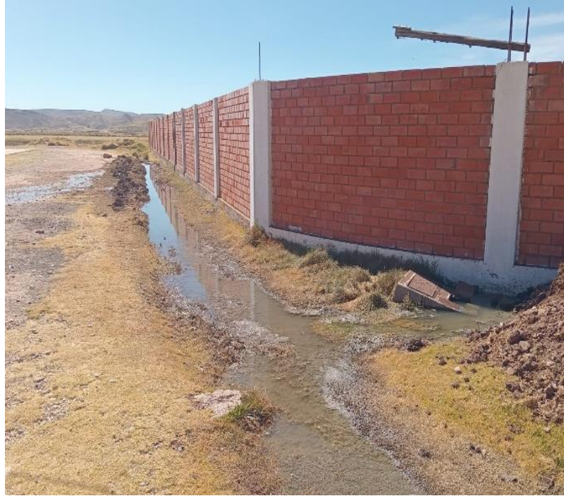
Descripción: Verificación in situ del colector en el mes de junio.
