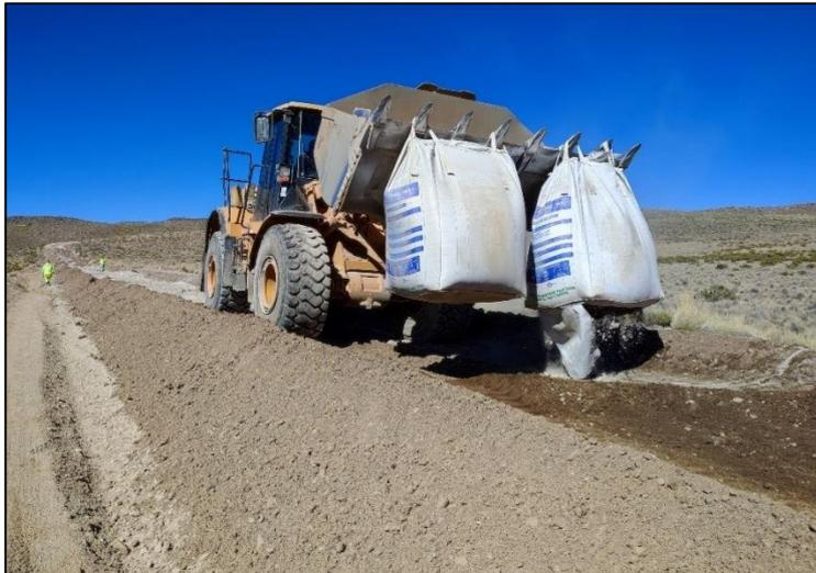
Nota. Se muestra el proceso de estabilización de suelos en un proyecto de construcción vial para mejorar sus propiedades físicas y mecánicas. Imagen propia.
