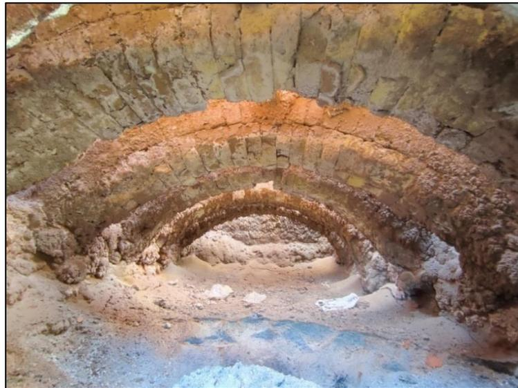
Nota. Se muestra la acumulación de los residuos de ceniza ubicado en la parte inferior de los hornos de ladrilleras.
