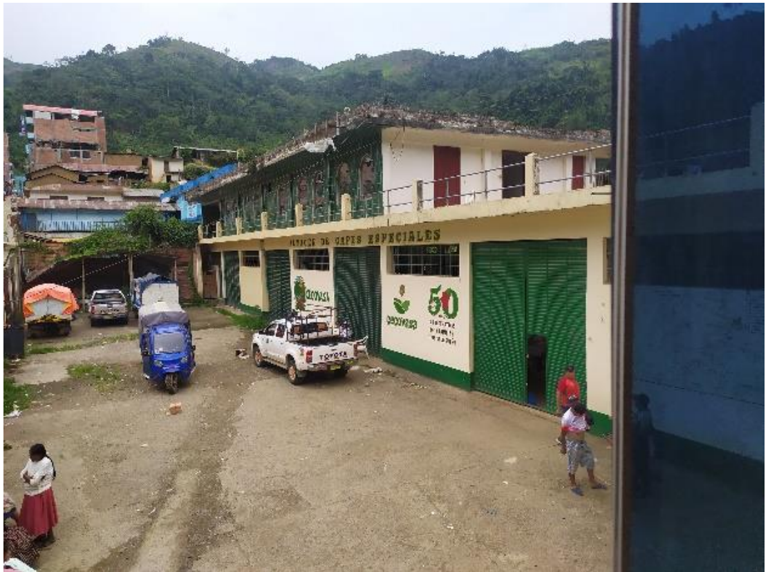
Instalaciones en San Pedro de Putina Punco
