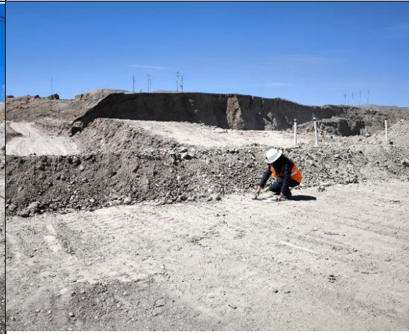
Instalación del punto de control N° 4
