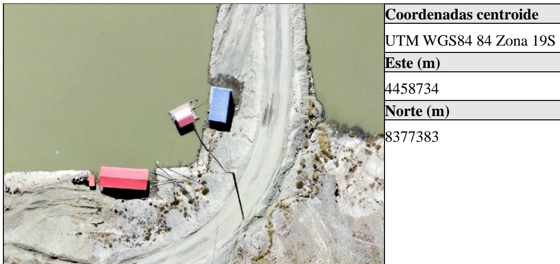
Área de motobomba 1
