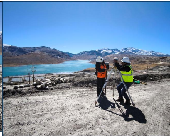
Imagen 2. Instalación del GPS diferencial (base y rover).
