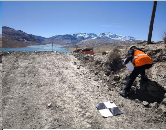
Instalación del punto de control N° 2
