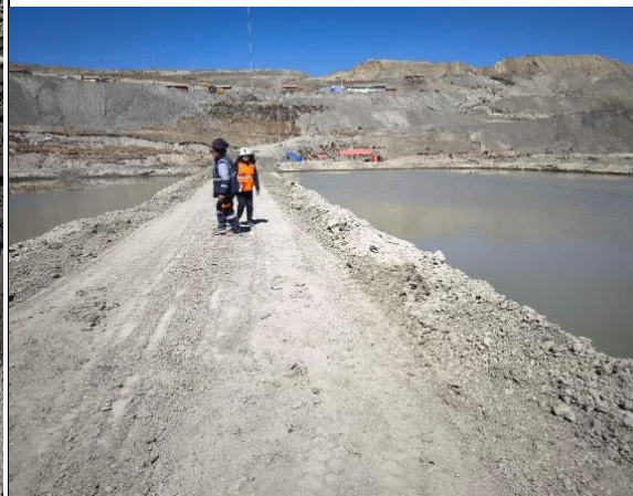
Instalación del punto de control N° 6
