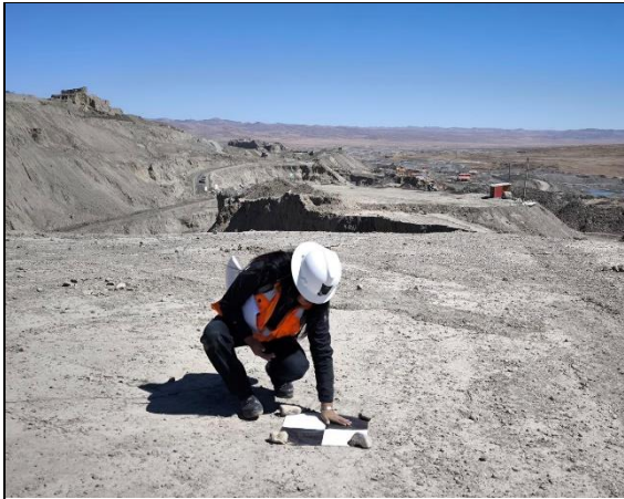
Instalación del punto de control N° 1
