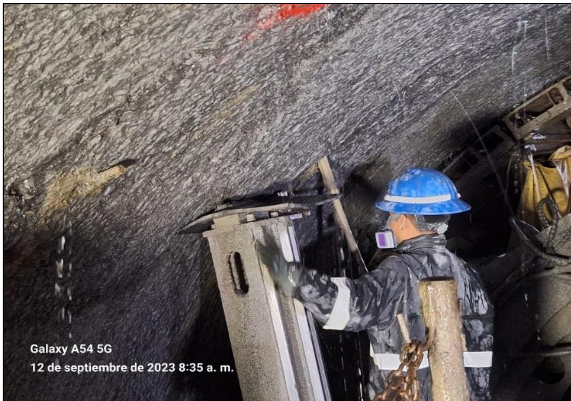
Figura 13. Perforación con jumbo para colocación de pernos de anclaje
