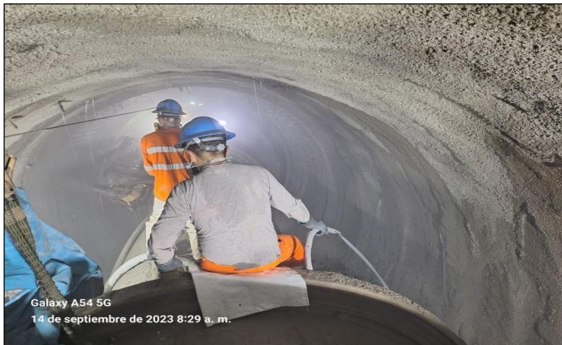
Figura 14. Lanzado de concreto en el túnel para sostenimiento
