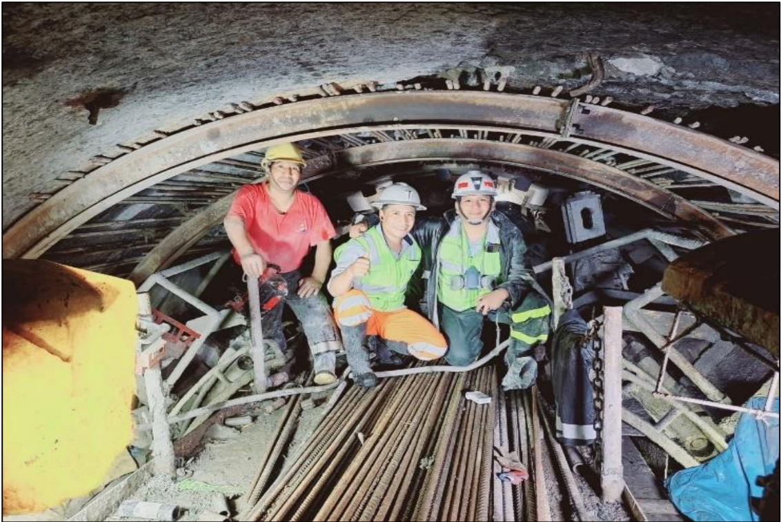
Figura 15. Sostenimiento con simbra y pernos de anclaje en roca tipo V.
