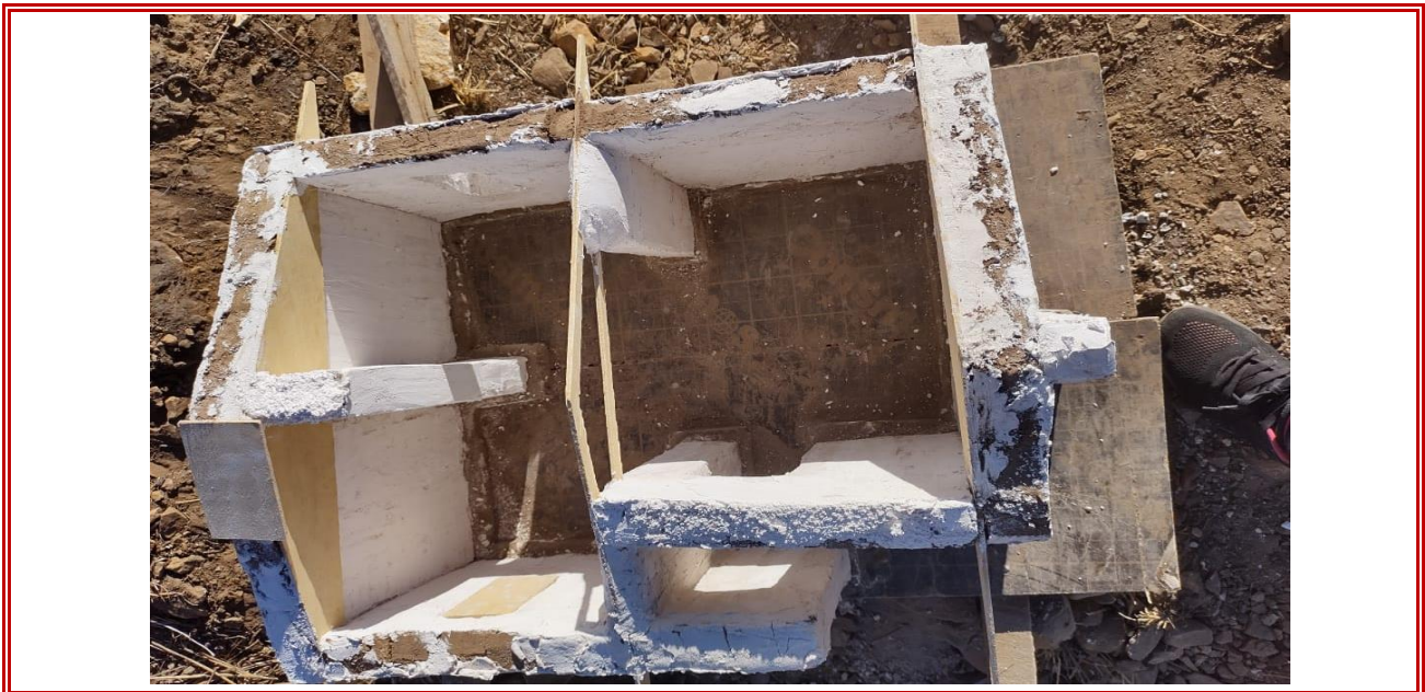
FOTOGRAFIA 30 DESCRIPCIÓN EN LA IMAGEN SE PUEDE OBSERVAR EL REVESTIMIENTO DE YESO DE PROTOTIPO
