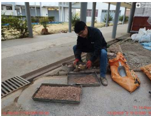
Tamizado de suelo para ensayo Proctor
