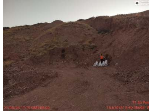
Extracción de suelo en cantera
