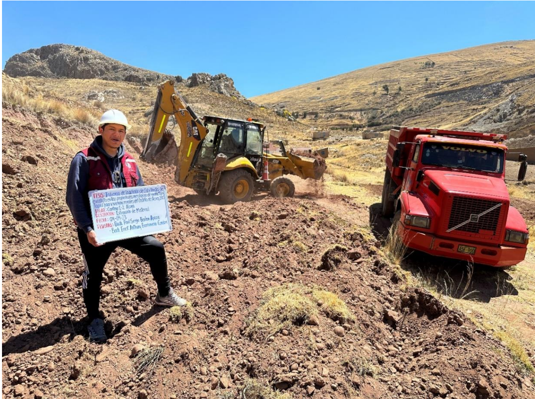
Fotografía 1. Extracción del material de la cantera C-3
