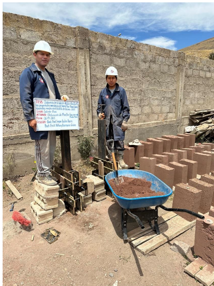
Fotografía 8. Elaboración de muretes
