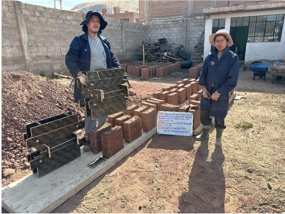
Fotografía 11. Desencofrado de los muretes elaborados
