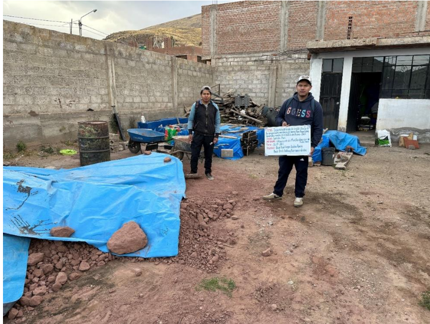
Fotografía 9. Protección de los muretes para el correcto secado
