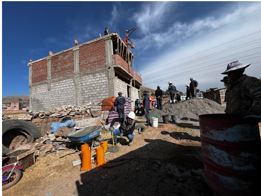
Slump de concreto de la vivienda V-18
