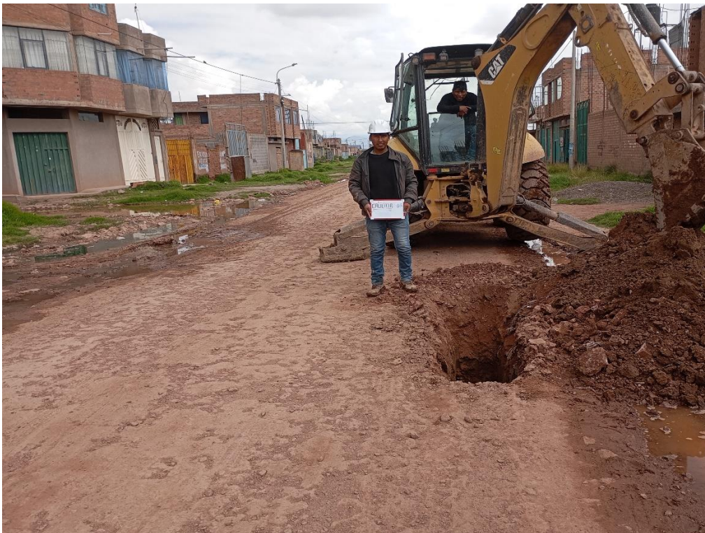
Fotografía N°04. Apertura de calicata N°06 con Maquinaria.
