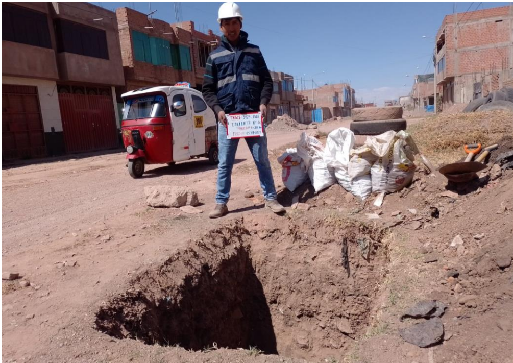
Fotografía N°01. Apertura de calicata N°01 por método manual.
