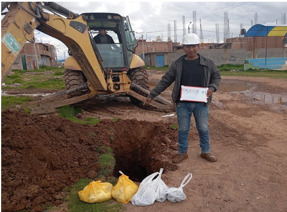
Fotografía N°05. Apertura de calicata N°07 con Maquinaria.
