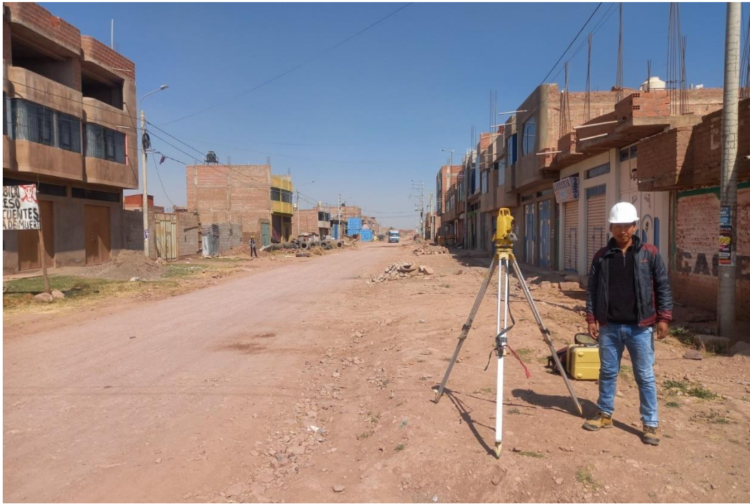
Fotografía N°23. Levantamiento Topográfico con estación total de la Av. Los Virreyes Juliaca – Puno
