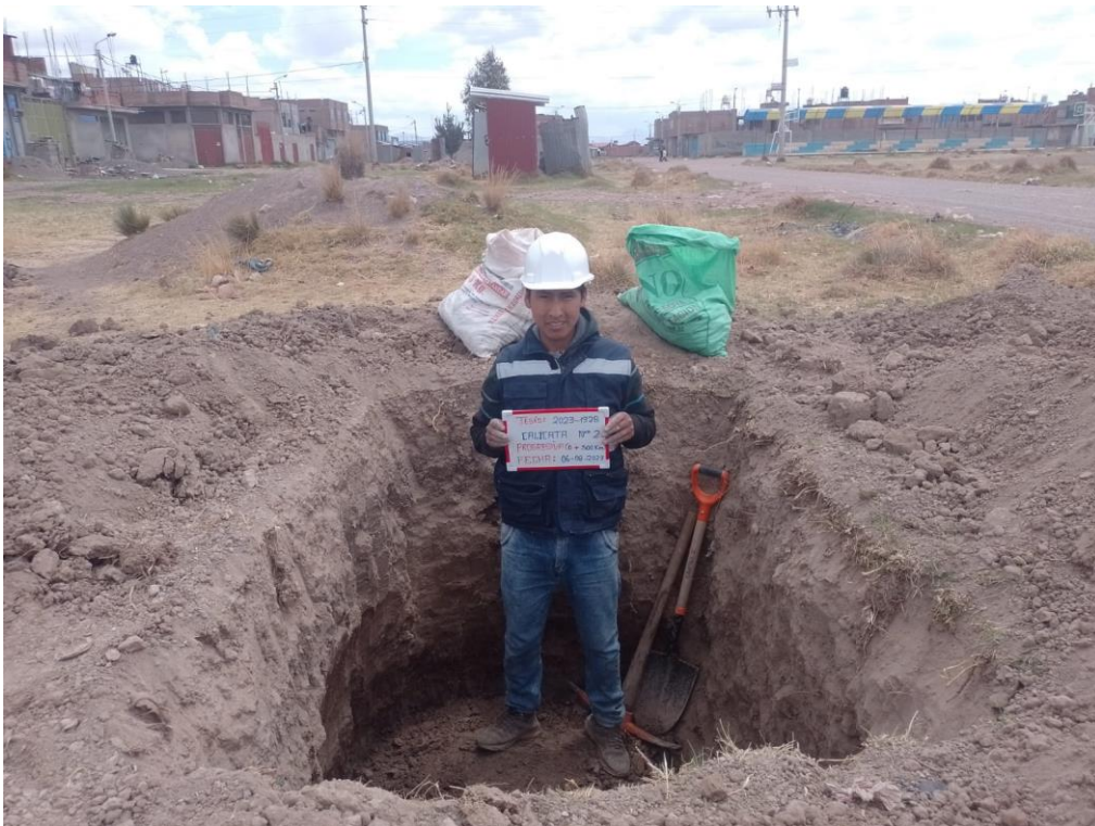
Fotografía N°02. Apertura de calicata N°02 por método manual.
