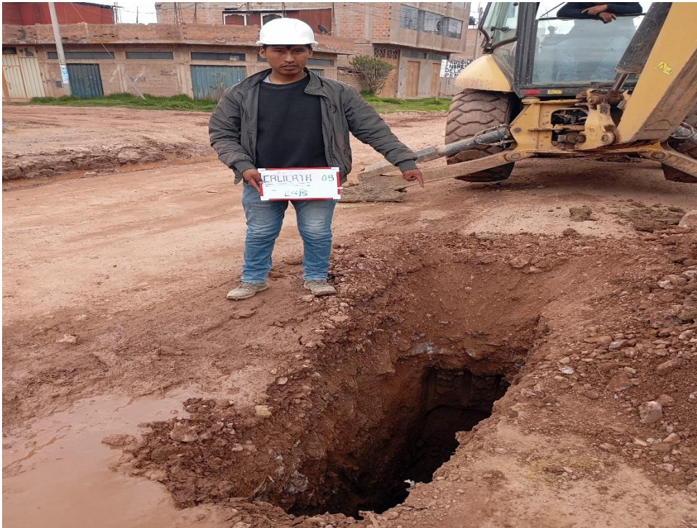
Fotografía N°03. Apertura de calicata N°05 con Maquinaria
