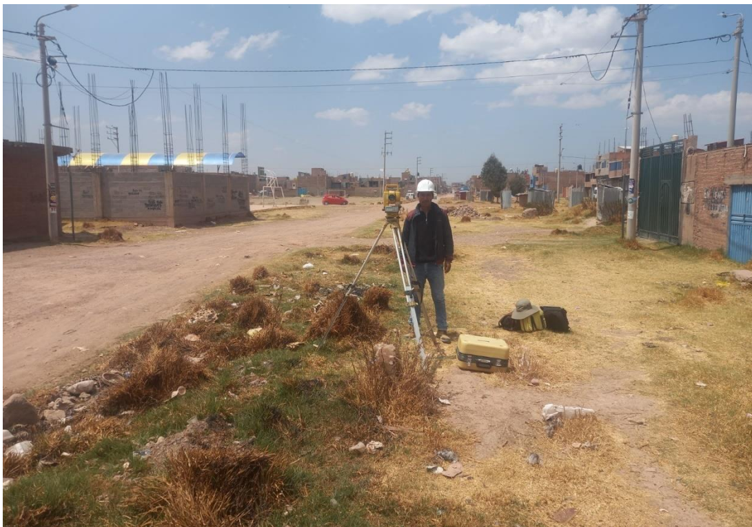
Fotografía N°24. Levantamiento Topográfico con estación total de la Av. Los Virreyes Juliaca – Puno
