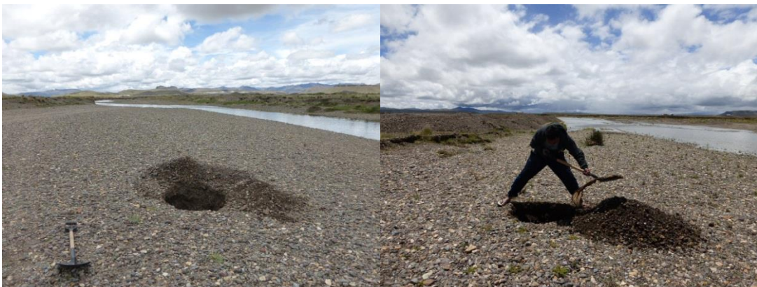
Calicatas en los aluviales
