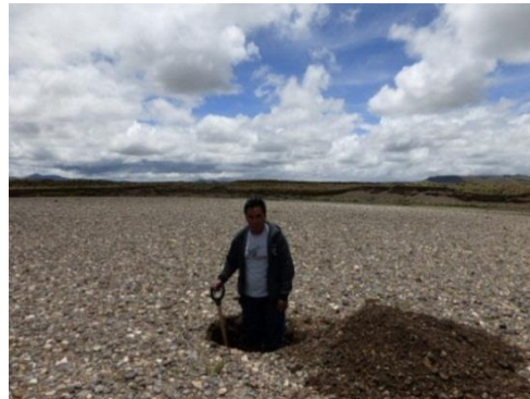
Figura N° 20: Excavación de calicatas en los aluviones
