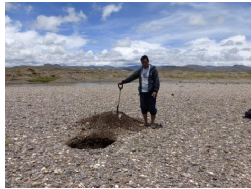
calicatas en los aluviales
