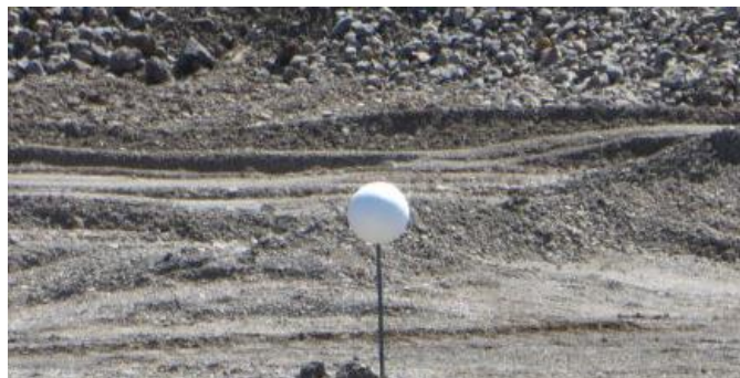
Figura N° 30: Colocación de esferas
